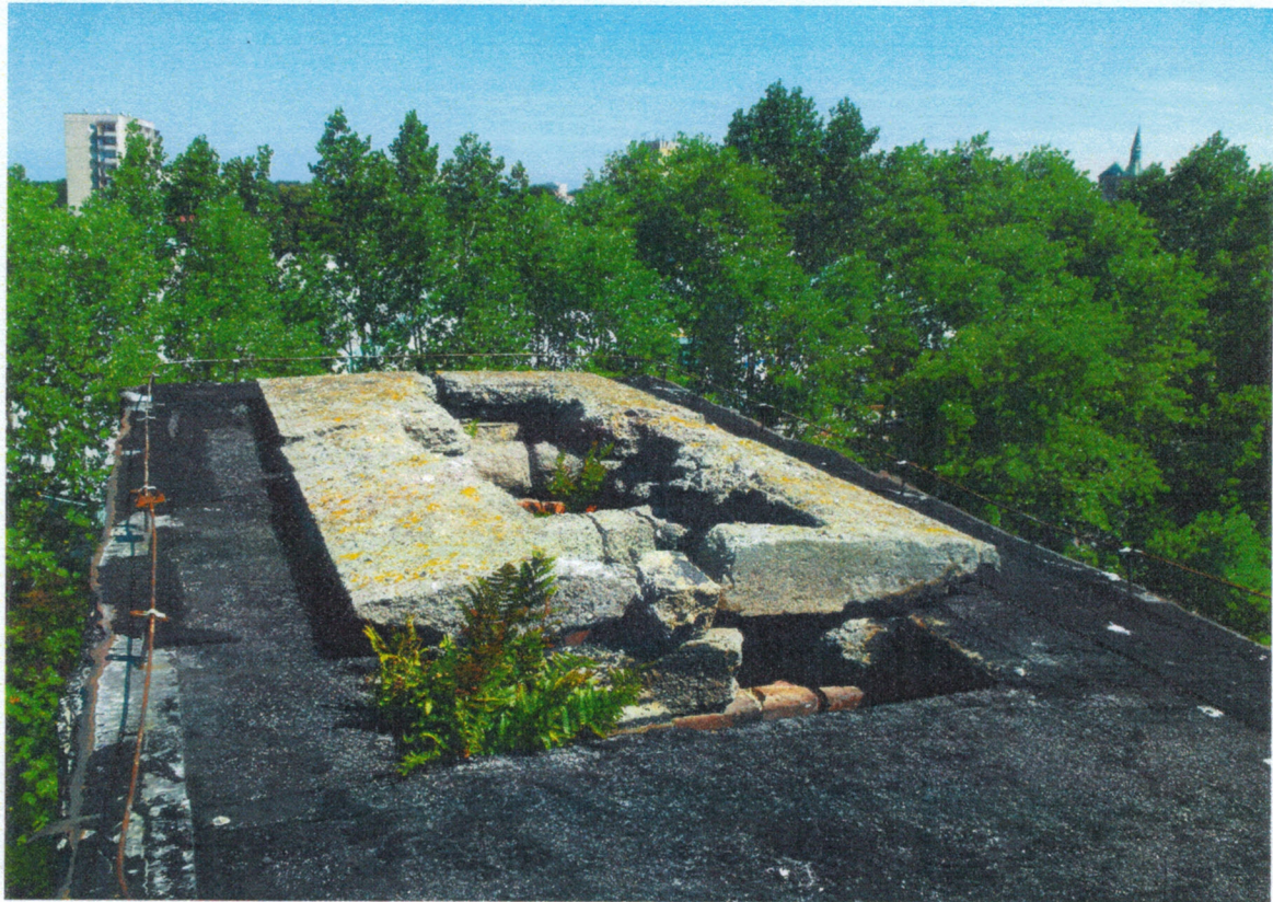
Zdjęcie nr 5 Zdjęcie górnej płyty okapowej komina wewnętrznych kanałów i całego komina
