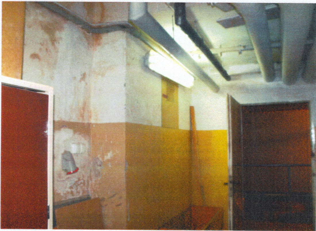
Zdjęcie nr 7 częściowy widok komina w pomieszczeniu piwnic.
