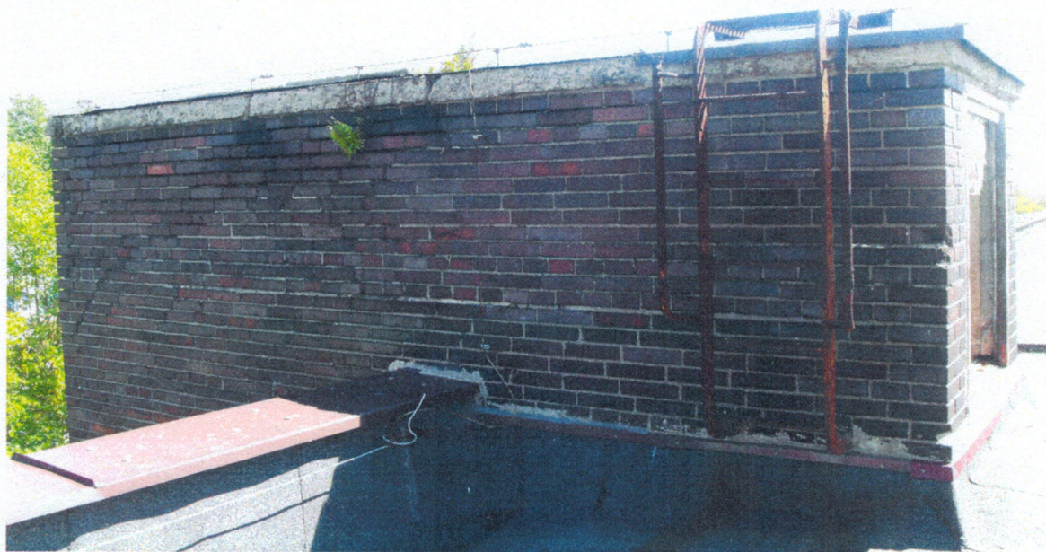
Zdjęcie nr 2 widok komina nad dachem budynku od strony półn-zach
