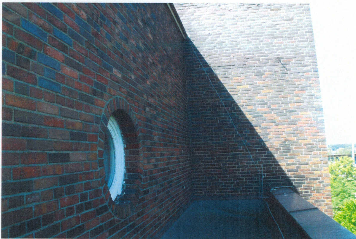
Zdjęcie nr 3 widok komina z dachu nad II piętrem od strony południowej
